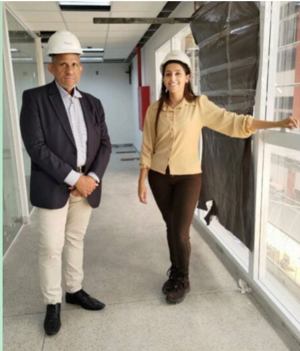
Visita às obras do novo fórum de Alagoinhas
