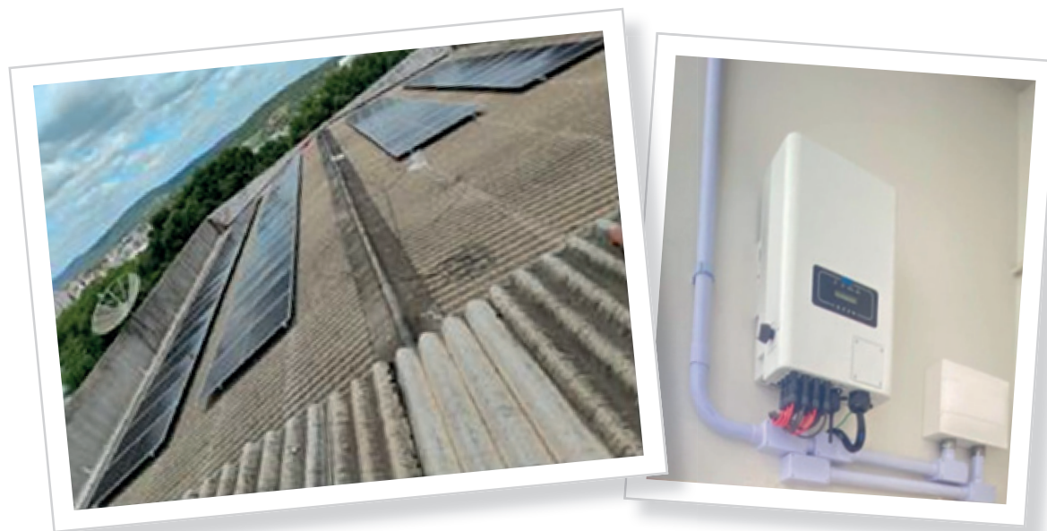
Status: Instalação concluída
