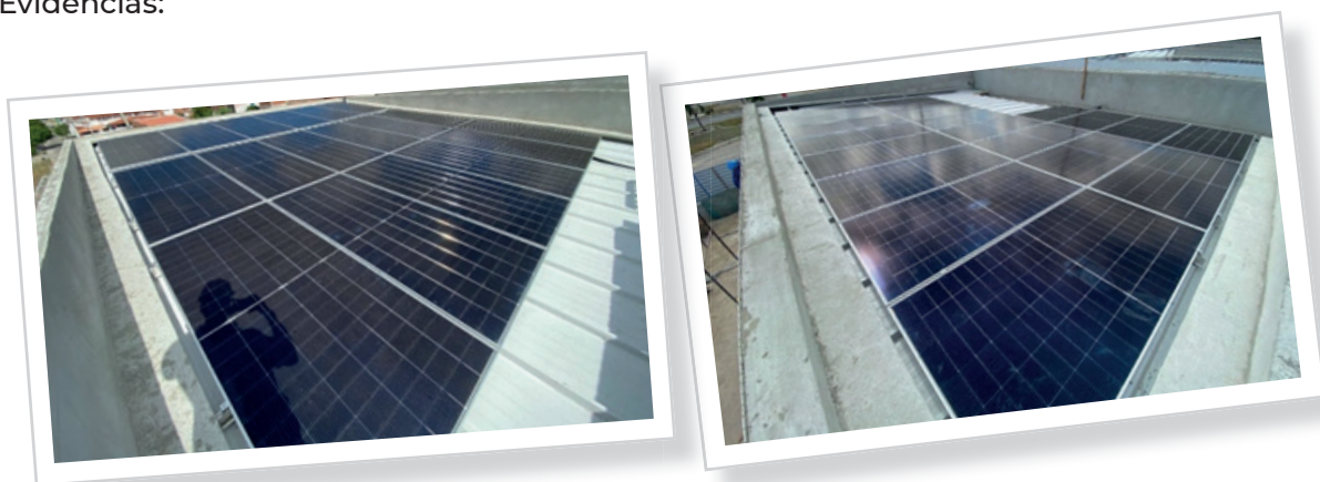
Status: Instalação concluída
