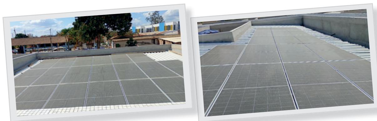
Status: Instalação concluída
