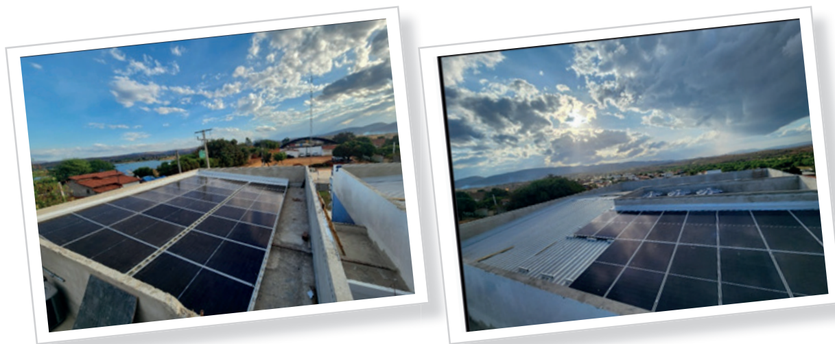
Status: Instalação concluída
