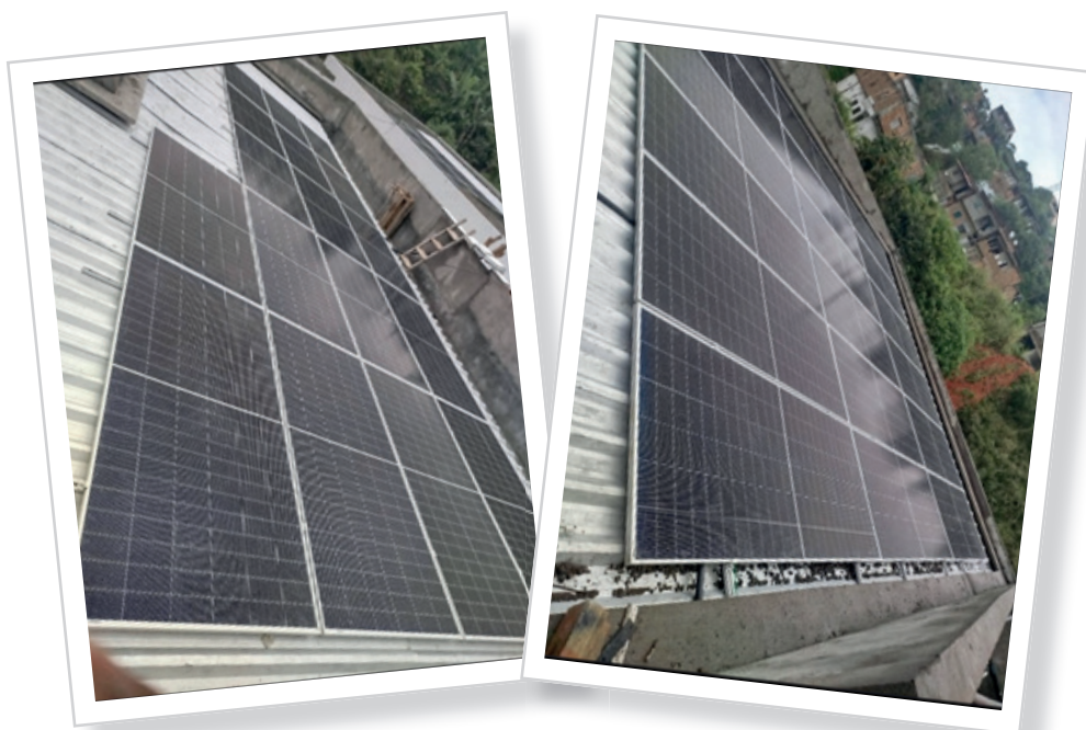
Status: Instalação concluída
